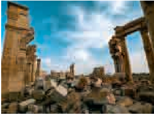
Fig. 6. Palmira. L'arco monumentale all'inizio della via colonnata dopo la distruzione
