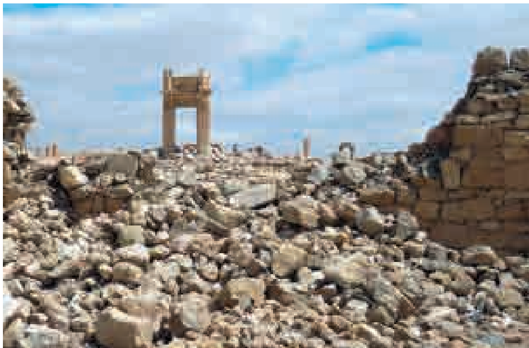
Fig. 3. Palmira. Il Tempio di Bel dopo la distruzione Fig. 3. Palmyra. The Temple of Bel after its destruction
