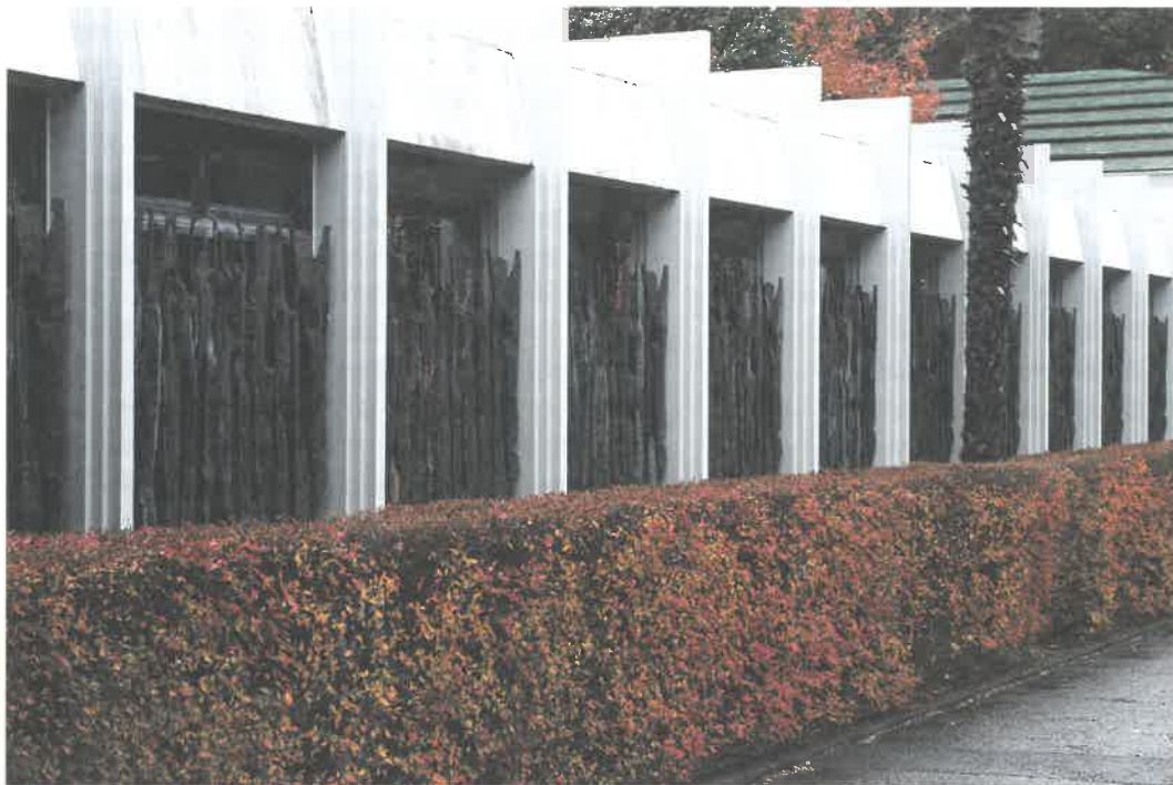
Fig. 6.30 Stessa inferriata vista dall'esterno. 外側から見た鉄柵
